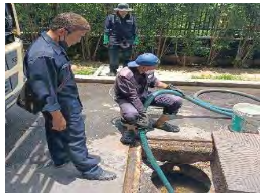
สูบล้างและไขน้จาบบบำบัดน้ำเสีย
