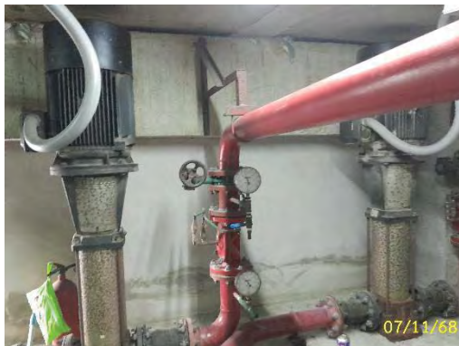
ระบบปั้มน้ำใช้ชั้นใต้ดิน
