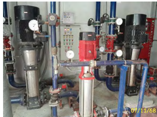
ระบบปั้มน้ำใช้ชั้นใต้ดิน
